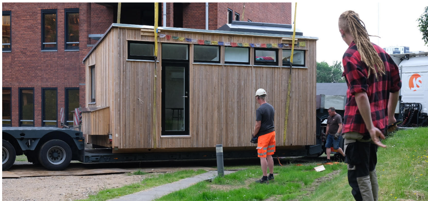
Afslutning på projekt Byg Udenfor i Århus: Ung fhv. hjemløs mand ser sin færdige bolig, som han har været medbygger på, blive placeret. Foto: Kim P. Olesen
