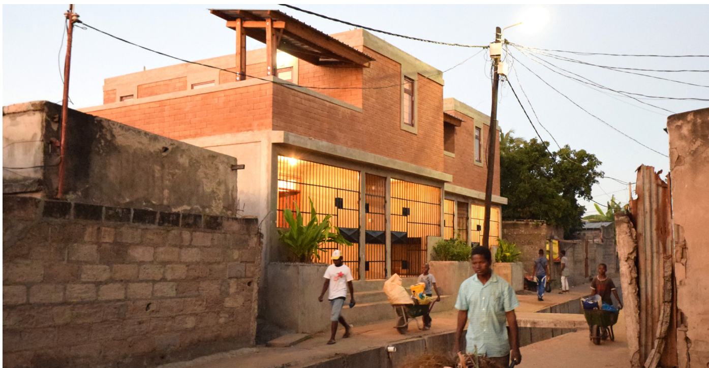
I 2018 blev denne prototype på billigt byggeri færdiggjort i projektet Casas Melhoradas i slummen i Maputo, Mozambique.
