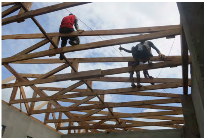
Påbegyndelse af tagkonstruktion
