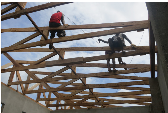
Påbegyndelse af tagkonstruktion
