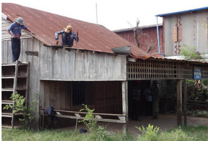
Nedrivning på sitet i Cambodia
